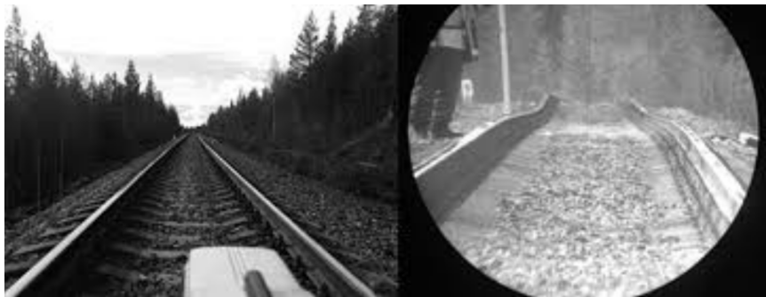
Рис. 2.6. Процес нівелювання залізничної колії. Вигляд поздовжнього профілю колії звичайним поглядом (зліва) та через трубу нівеліру (справа)
