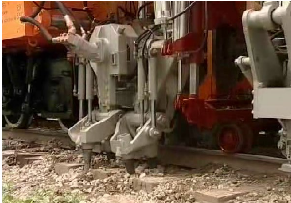
Рис. 5.10. Ущільнення баласту під шпалою підбійками підбивного блоку
