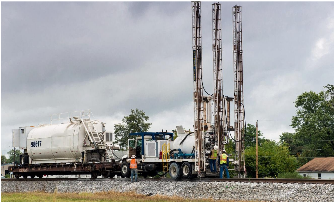
Рисунок 1.18 – Ін’єктування розчину у хворе земляне полотно [86]
