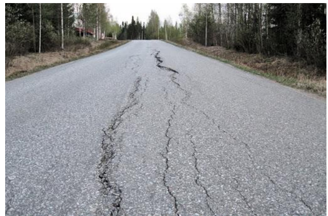
Рисунок 1.6 – Наслідки розуцільнення ґрунтів земляного полотна: a – залізничної колії; b – автомобільної дороги [24]
