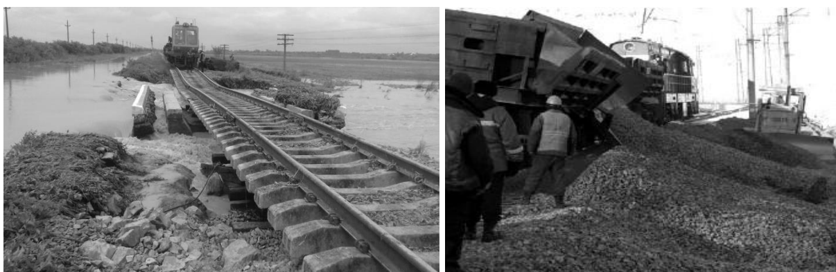
Рисунок 1.3 – Руйнування та розмив насипу залізничної колії під час паводків: a – на 224-й кілометрі перегону Заболотів – Видинів [4]; b – на 124 км ділянці Львів – Самбір – Ужгород [5]
