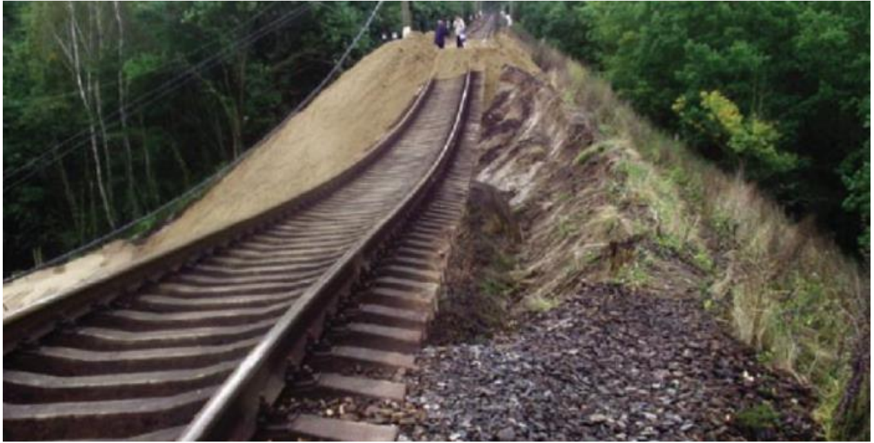
Рисунок 1.5 – Втрата стійкості земляного полотна
