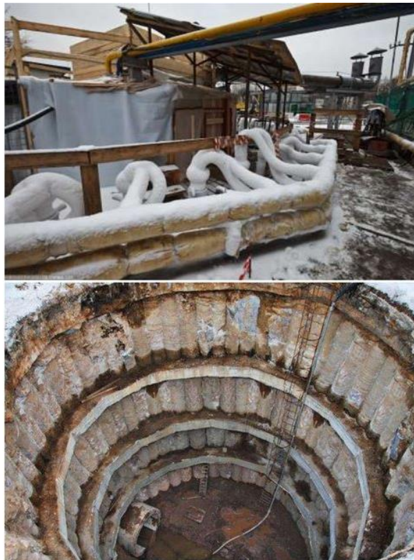
Рисунок 1.4 – Схема розсолпроводної мережі під час будівництва шахтного стовбуру
