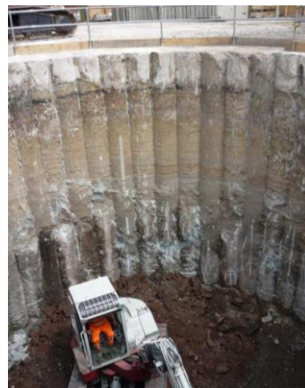
Рисунок 1.2 – Вертикальна виробка при закріпленні ґрунту технологією «стіна в ґрунті» з буросічних паль
