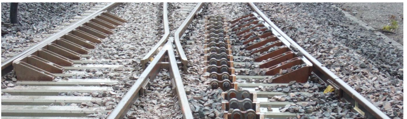
Рис. 1.4. Конструкція залізобетонних брусів для стрілочних переводів німецької компанії RAIL.ONE
