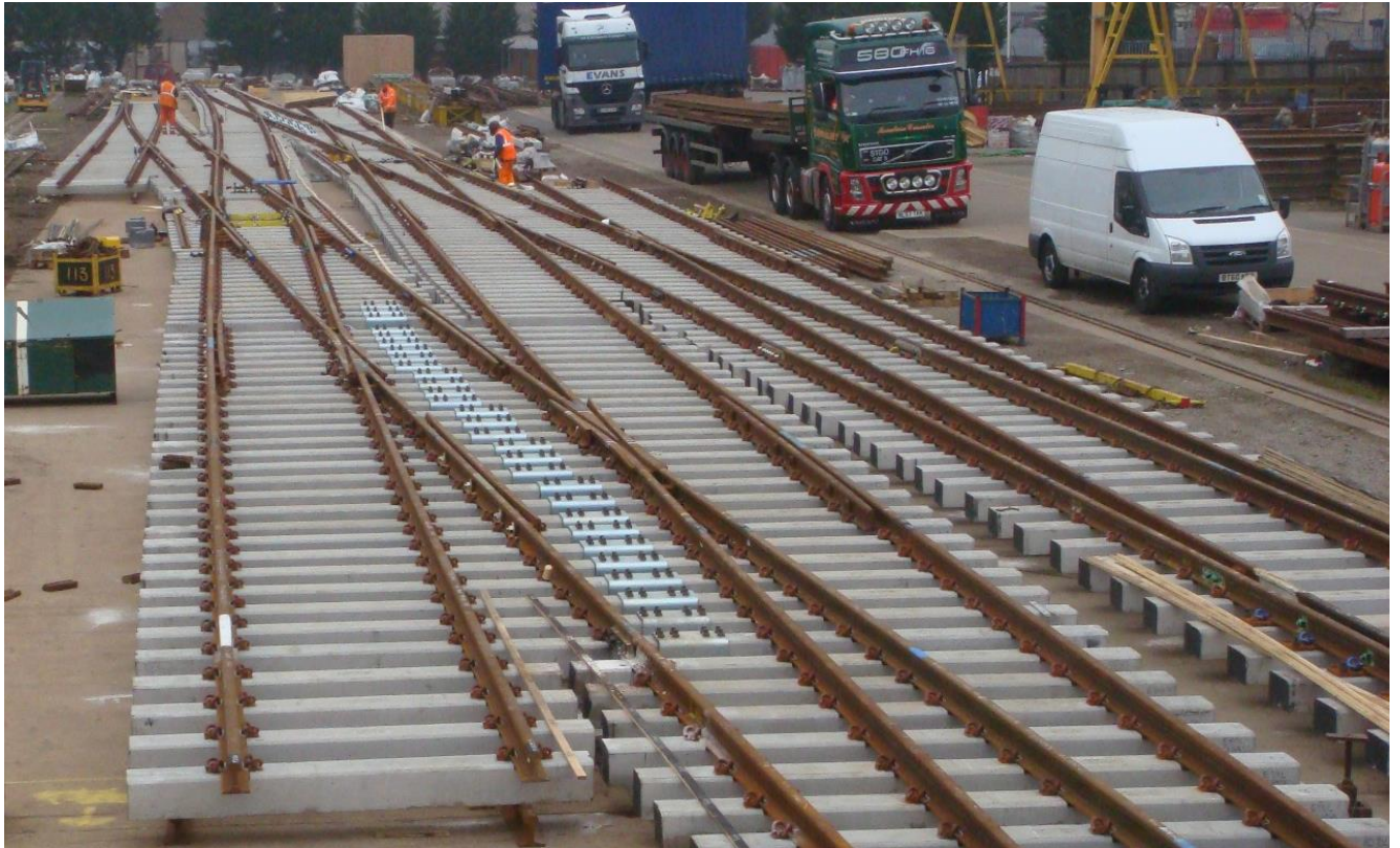
Рис. 1.8. Укладання комбінацій стрілочних переводів в районі Crofton Road у Лондоні
