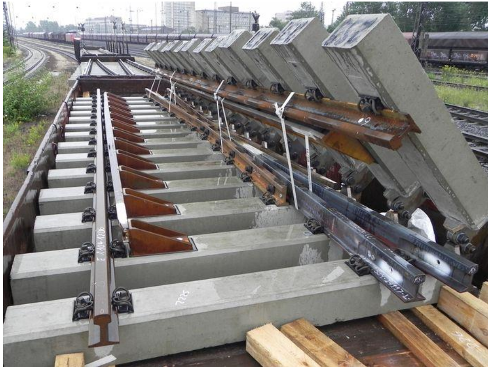
Рис. 1.3. Транспортування розкладних блоків стрілочних переводів
