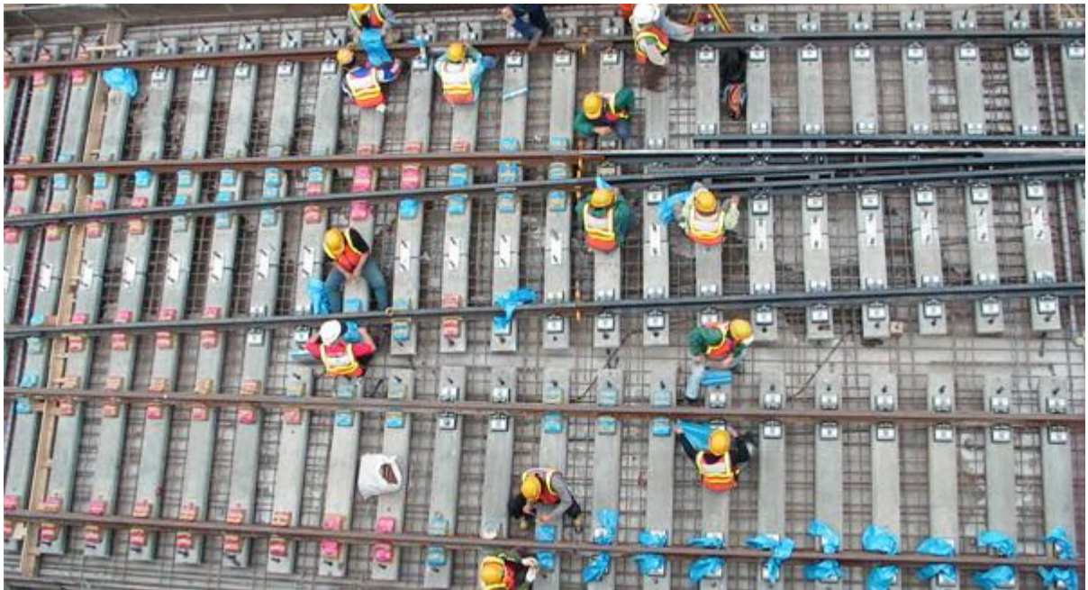
Рис. 1.5. Підготовка стрілочного з'їзду до бетонування підрейкової основи
