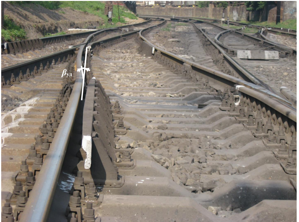
Рис. 2.14. Схема вкороченого стрілочного з'їзду з кутом удару перед хрестовиною
